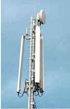
typische Mobilfunkbasisstation mit drei Sektorantennen und Richtfunk
